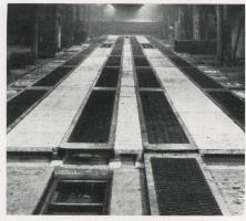
Die erste Probeanlage bei Baldwin-Auger. Die Wagen werden auf zwei geriffelte Schiebeflächen gestellt, vom Besitzer abgeschlossen und mechanisch weiterbefördert. Die beiden Plätze am Anfang und am Ende der Doppelreihe lassen sich quer verschieben, die übrigen nur längs. Die beweglichen Bodenteile (trolleys) werden durch eine endlose Kette in der Längsrichtung fortbewegt. Ein Platz bleibt stets leer, damit manövriert werden kann.
