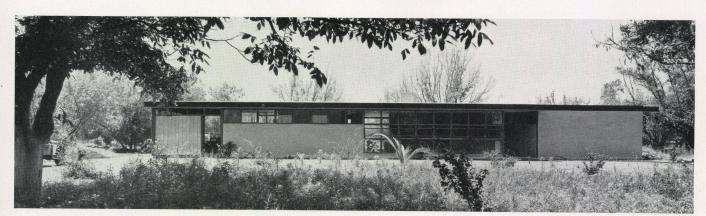
Die Tragkonstruktion besteht aus 3 Reihen von je 8 Stahlsäulen. Ax-Abstand 3,60 m. Dachkonstruktion aus T-Trägern und 20 cm hohen Längsträgern. Querwände mit Diagonalverstrebung.
