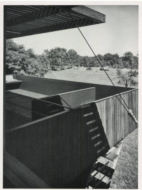
Der an Stahlkabeln aufgehängte Holzbalkon mit Treppe ins Freie.
