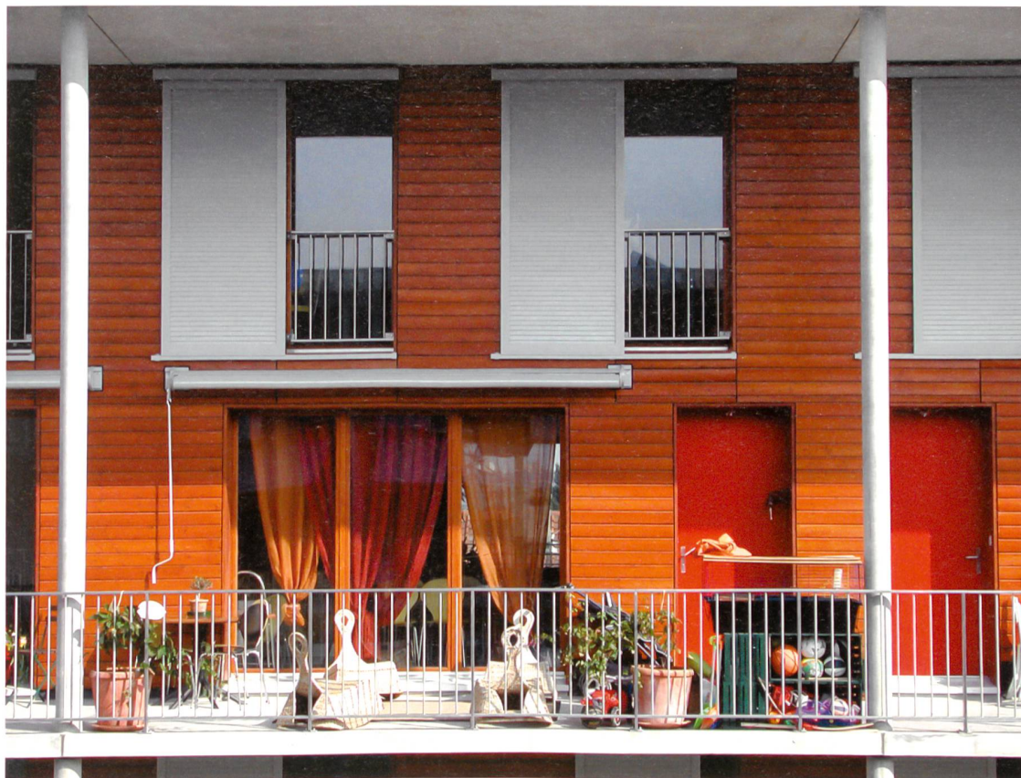
1 L'immeuble Les Ouches à Genève, première opération neuve de la CODHA, livré en 2004 (© CODHA)
