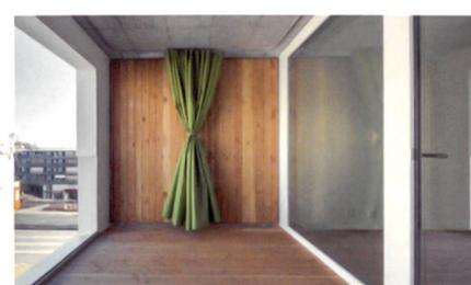
Au total, 831 fenêtres et portes-fenêtres en formats standard et spécifiques ont été montées. Leur structure multichambre assure une excellente isolation et offre une valeur U de 0,7 W/m<sup>2</sup>K et une protection acoustique de 38 dB pour répondre ainsi aux standards écologiques exigés. Les seuils de 25 mm permettent aux personnes à mobilité réduite de passer les portes-fenêtres sans problème.
