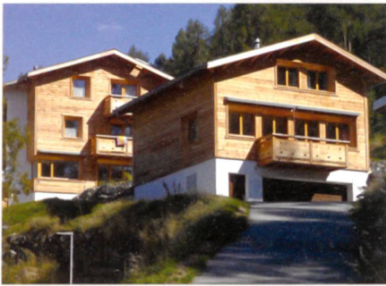
Fig. 1: Maisons Lundström, deux maisons Minergie-P-ECO à Nax (VS) (photoTL)
