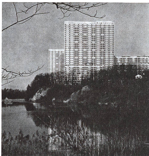
Fig. 35. — Immeuble d'habitation du Lignon, Genève 1965. Vue des tours de 30 et 26 étages.
