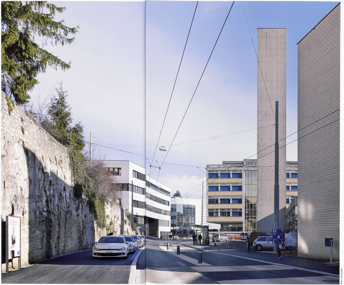
Vue sur Microcity depuis la rue de la Maladière, côté ouest
