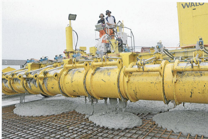
Coulage du béton devant la machine de pose (Photo Hartmut Mühlberg)
