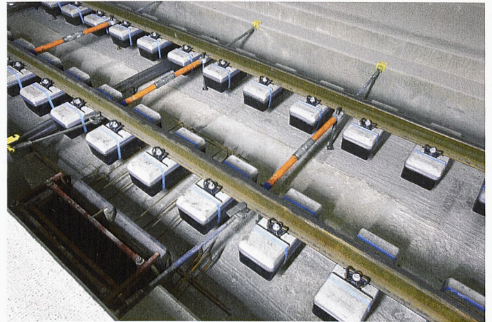
Blochets suspendus aux rails avant bétonnage (© Alpransit Gotthard AG)
