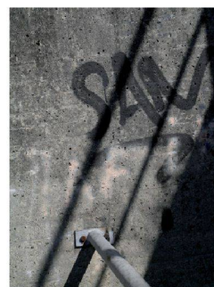
Graffiti sur un mur en béton (Photo AHO)
