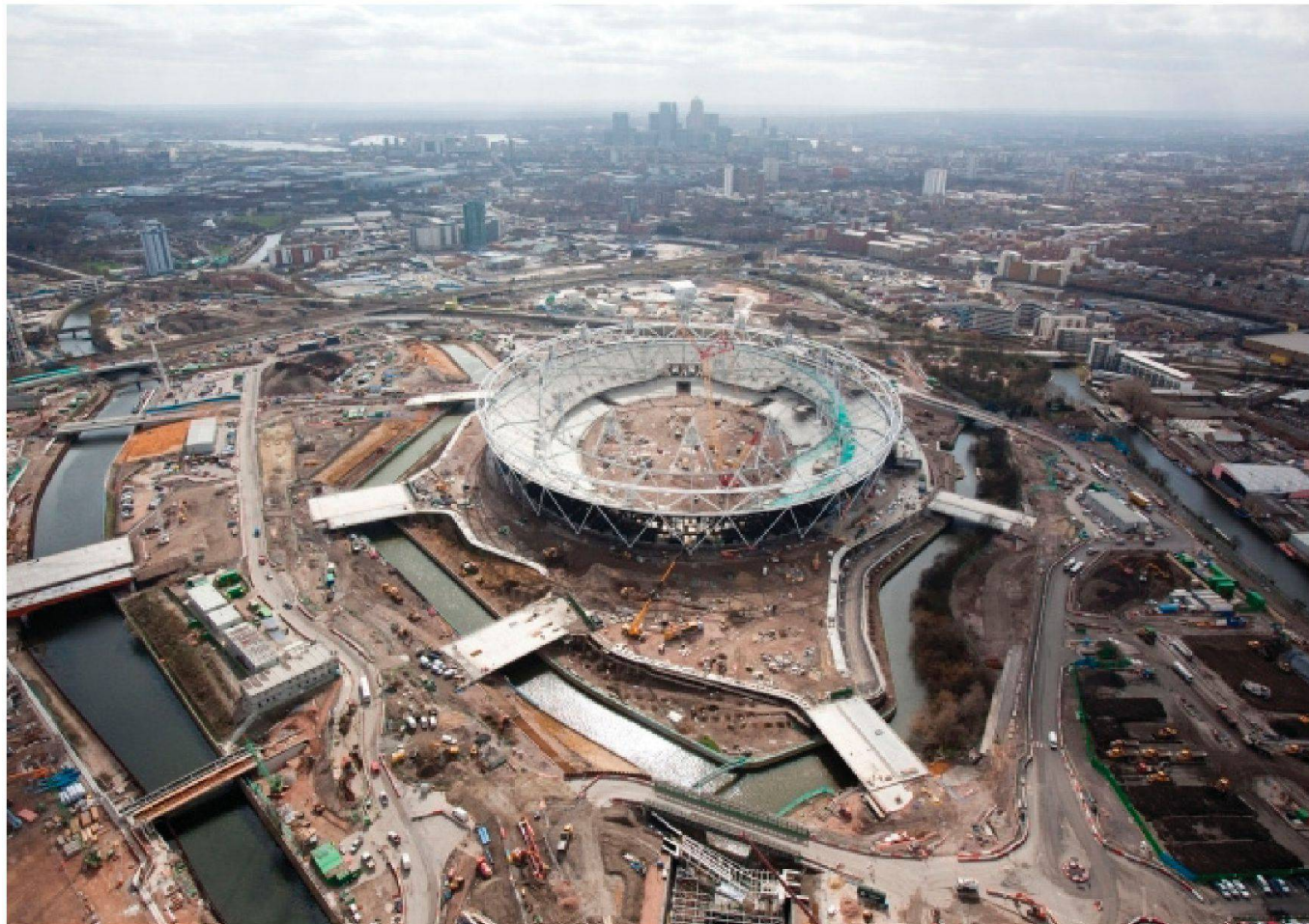
Vue aérienne du parc olympique de Londres en chantier, sécurisation des accès et du stade par les enceintes d'eaux (London 2012)
