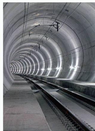
Tunnel de base du Lötschberg (Photo Thomas Ardenmatten)
