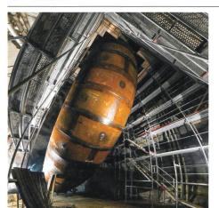
Coude de la conduite blindée au bas de l'un des deux puits verticaux de la centrale de pompage-turbinage de Nant de Drance (photo Nant de Drance SA)
