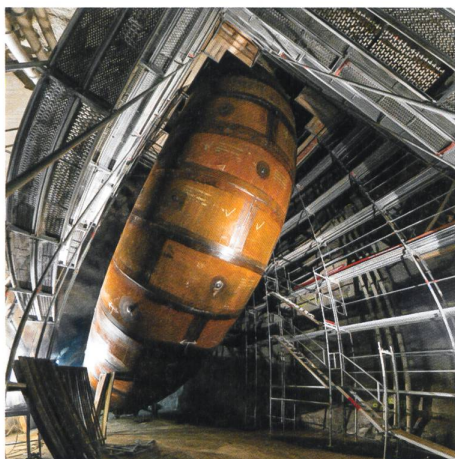
Coude de la conduite blindée au bas de l'un des deux puits verticaux de la centrale de pompage-turbinage de Nant de Drance (photo Nant de Drance SA)
