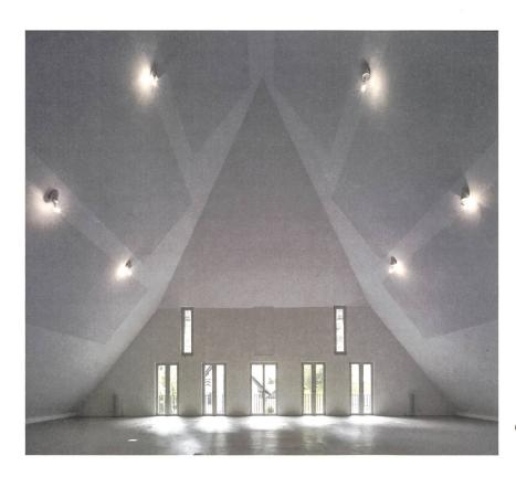
6 Comme la toiture est autoportante, les grandes salles polyvalente et d'exposition de la maquette Martini peuvent être entièrement dégagées. (© Marco Bakker)
