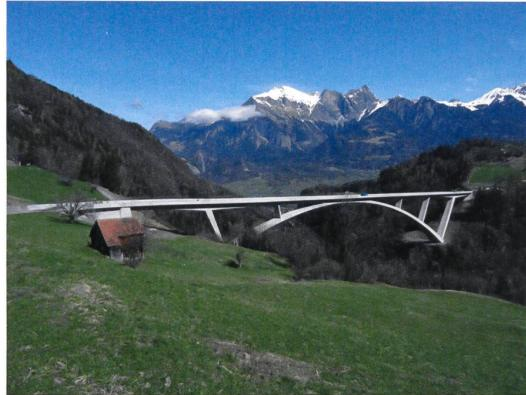
Après quatre ans de travaux, le pont sur la Tamina a été ouvert en juin. Des chiffres impressionnantes le caractérisent : un arc asymétrique en béton précontraint de 260 m, des piliers hauts de 78,5 m, une clé de voûte surplombant la vallée à 200 m, un poids de 35 000 t, 14 000 m<sup>3</sup> de béton coulé sur site, etc. MAPEI a été impliquée de A à Z et a livré des adjuvants et produits adaptés. Ses compétences et l'efficacité de ses produits ont permis la réalisation de ce bel ouvrage.
