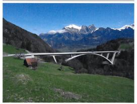
Après quatre ans de travaux, le pont sur la Tamina a été ouvert en juin. Des chiffres impressionnants le caractérisent : un arc asymétrique en béton précontraint de 260 m, des piliers hauts de 78,5 m, une clé de voûte surplombant la vallée à 200 m, un poids de 35 000 t, 14 000 m³ de béton coulé sur site, etc. MAPEI a été impliquée de A à Z et a livré des adjuvants et produits adaptés. Ses compétences et l'efficacité de ses produits ont permis la réalisation de ce bel ouvrage.
