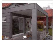
Les jardins d'hiver, les piscines, les bâtiments annexes, etc. peuvent s'affaisser au cours du temps et s'incliner. Ces affaissements peuvent entraîner ainsi la formation de fissures sur les éléments de construction et/ou un écartement entre la structure des jardins d'hiver, bâtiments annexes, etc. et celle du bâtiment principal. Les dommages occasionnés suite à un affaissement surviennent souvent même lorsqu'une construction a été correctement effectuée.
