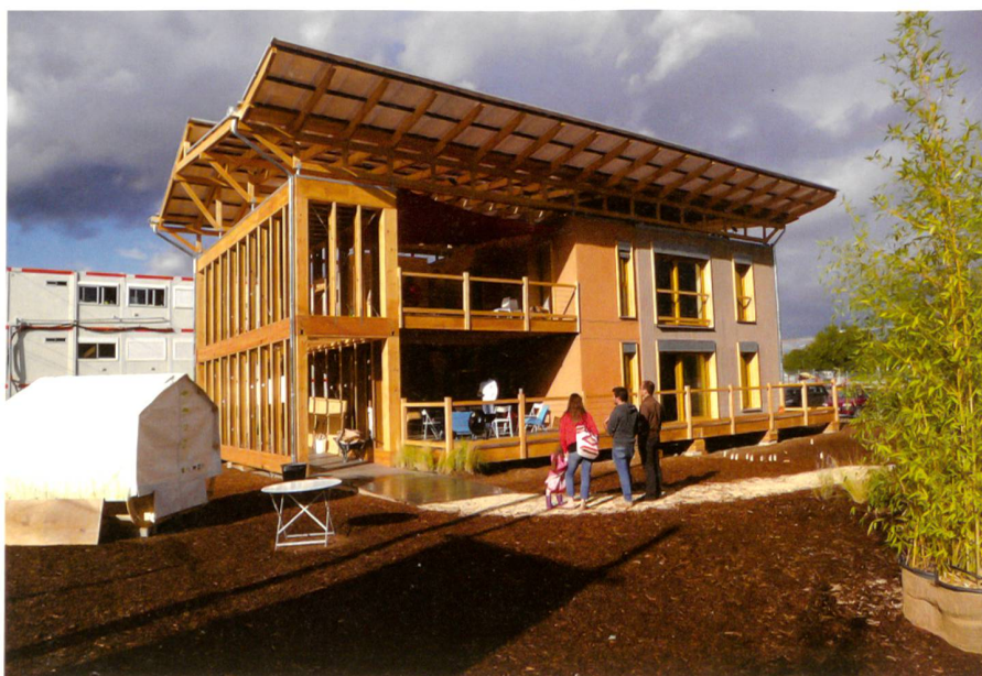
5 Terra Nostra, le prototype de deux étages d'un petit collectif d'habitat aux logements évolutifs, a été conçu et construit en bois et terre non stabilisée par les étudiants de l'équipe pluridisciplinaire Team Auvergne Rhône-Alpes. Ici au cœur de la Zac Confluence à Lyon, en juillet 2016. (Photo Ariane Wilson)
