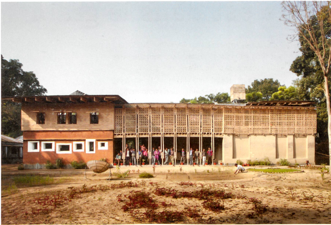
1 Le centre de formation pour électriciens à Rudrapur au Bangladesh (finaliste du Terra Award) fonctionne entièrement à l'énergie solaire. Etudiants bangladais et autrichiens, ouvriers locaux et futurs usagers ont érigé le bâtiment conçu par Anna Heringer en 2008 pour une ONG locale. Les murs sont en bauge d'argile et paille de riz, la charpente en bambou, utilisé aussi pour les parois brise-soleil. (Photo Kurt Hoerbst)
