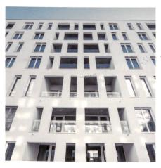
Au total, 831 fenêtres et portes-fenêtres en formats standard et spécifiques ont été montées. Leur structure multichambre assure une excellente isolation et offre une valeur U de 0,7 W/m<sup>2</sup>K et une protection acoustique de 38 dB pour répondre ainsi aux standards écologiques exigés. Les seuils de 25 mm permettent aux personnes à mobilité réduite de passer les portes-fenêtres sans problème.
