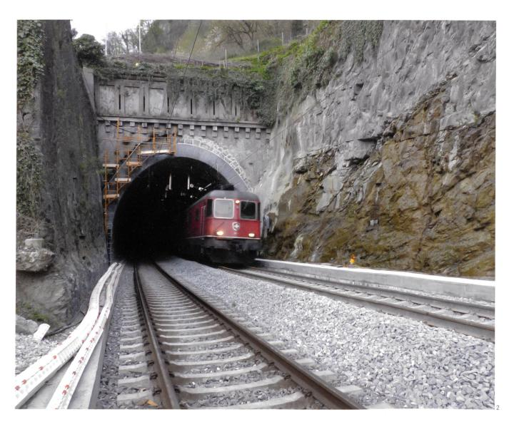
stué sur la ligne Lausanne-Brigue et mis en service en 1859, le tunnel de St-Maurice a une longueur de 489 mètres, dont 35 de tranchée couverte côté St-Maurice. Excavé dans du calcaire, il n'est revêtu de moellons qu'au nord sur une longueur de 150 m.
