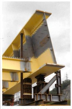
Détail d'une poutre longitudinale du pont ferroviaire de Massongex (photo Hartmut Mühlberg, Monod-Piguet + Associés Ingénieurs Conseils SA)
