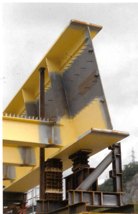
Détail d'une poutre longitudinale du pont ferroviaire de Massongex (photo Hartmut Mühlberg, Monod-Piguet + Associés Ingénieurs Conseils SA)
