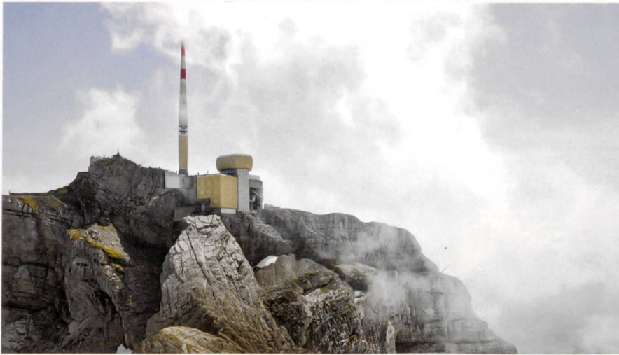
Gare d'arrivée du funiculaire du Sântis, Schwägälp (AR), construit en 1968-1974 par Esther et Rudolf Guyer (photo Sebastian Heeb, Patrimoine suisse)
