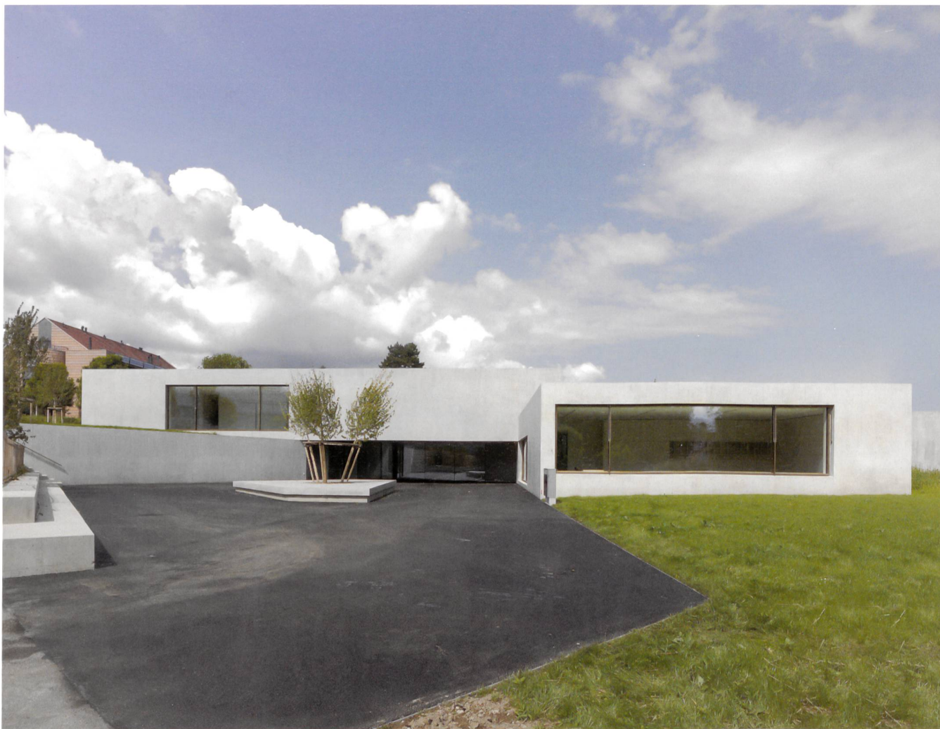
7 Vue de l'entrée (Tous les documents illustrant cet article sont du bureau PIERRE-ALAIN DUPRAZ ARCHITECTE ETS FAS, Genève et les photos de Thomas Jantscher)
