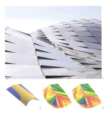
peau vitrée, il présente en outre un intérêt technique important car une nouvelle génération de machines industrielles permet de produire des panneaux de verre trempé cylindriques sans moule.
