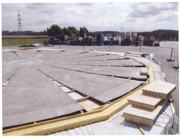
la forme de la coque pendant le gonflage et maintenir à sa place la membrane pneumatique sous-jacente, les fentes radiales étaient équipées de taquets pneumatiques dont la pression était aussi contrôlée (fig. 7). Une fois la coque formée, les ouvertures résiduelles ont été colmatées à l'aide de mortier de ciment (fig. 8).
