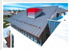
Pour la première fois, Schindler Suisse propose un ascenseur standard avec une tête de gaine mesurant 2,40 m seulement. La dernière version du Schindler 3300 rend ainsi inutiles les structures de toit.
