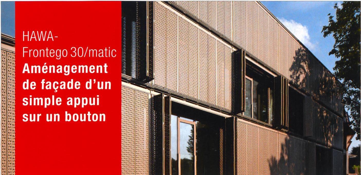
Le système de ferrures automatisé pour volets pliants coulissants fermant à fleur de façade HAWA-Frontego 30/matic offre à la fois une protection individualisée contre la vue et le soleil ainsi qu'un surcroît de sécurité. La commande et l'entraînement économise en énergie sont intégrés dans le système. [www.hawa.ch/frontego/](http://www.hawa.ch/frontego/)
