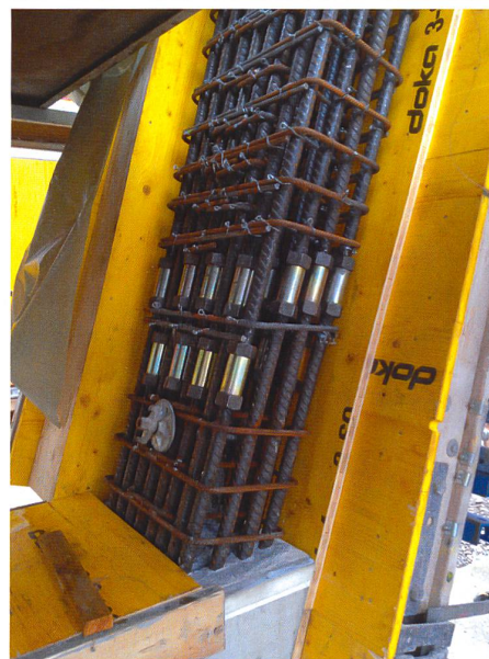
Armature à haute résistance Top700 dans les piliers, avec liaisons par filetage BARTEC®TOP
