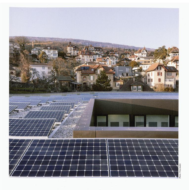
8 Centrale photovoltaïque installée sur la toiture du bâtiment, dont la réalisation par Viteos permet de fournir 224'500 kWh par année au réseau électrique de la ville, soit l'équivalent de la consommation d'environ 64 ménages
