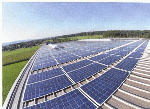
Revêtement photovoltaïque avec MONTANA-SOLbond Foto Jaisli Xamax, M. Werner
