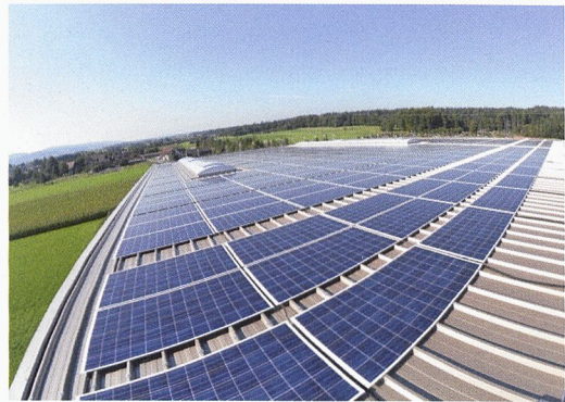
Revêtement photovoltaïque avec MONTANA-SOLbond Foto Jaisli Xamax, M. Werner
