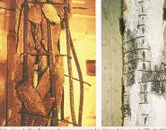
duction de l'écaillage par le resserrement des étriers bien ancrés (Photo Walter Borgogno
