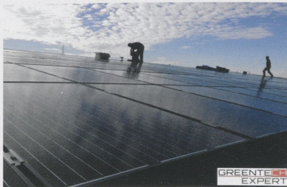
Installation de panneaux photovoltaïques sur la déchetterie des Gavardes, à Savigny (VD).
