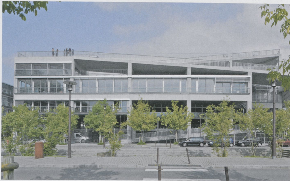
< La rampe d'une largeur exceptionnelle permet de monter des camions sur le toit. (Photo Philippe Ruault)
