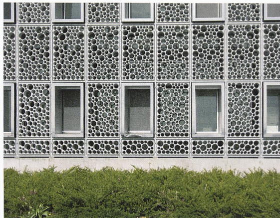
5, 6 BFUP utilisé en façade pour le bâtiment Swatch à Cormondrèche, dans le canton de Neuchâtel (Photos Eugen Brühwiler)
