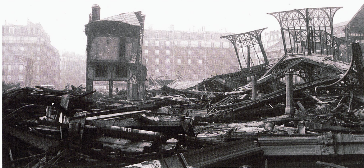
8 Démolition des pavillons Baltard, été 1972 (Photo François Chaslin)
