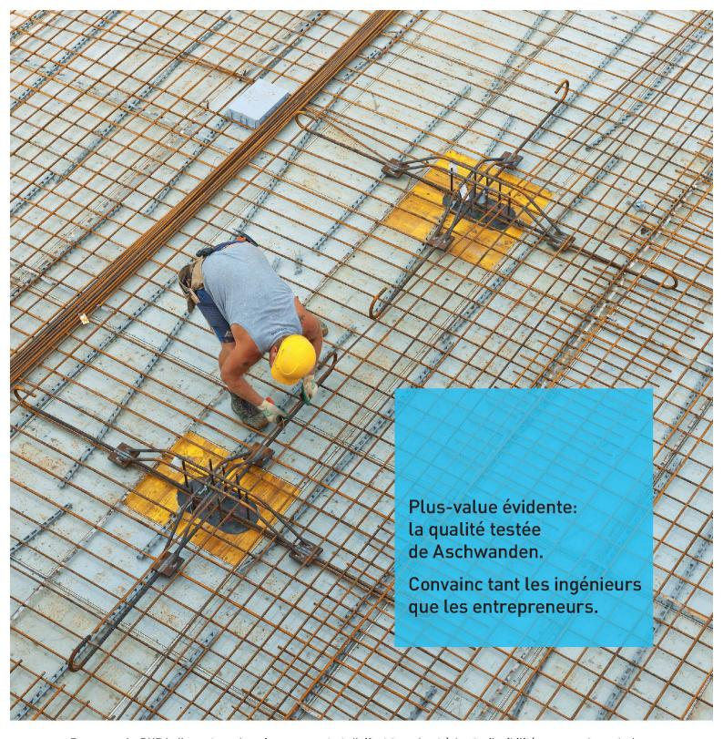
Par exemple DURA, l'armature de poinçonnement et d'effort tranchant à haute flexibilité, permet des solutions optimales et économiques. Aschwanden garantit sécurité et qualité avec des systèmes basés sur les normes. Des systèmes inégalés pour l'armature et la transmission de forces dans la construction en béton armé. Nos produits sont conçus par des spécialistes et avec la collaboration de hautes écoles selon les standards les plus sévères, et testés par l'EMPA ou l'EPFL.
