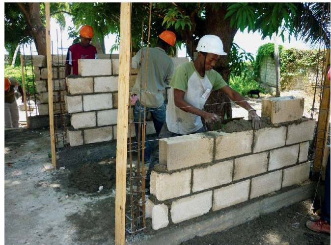
Atelier de formation de maçons (DDC/Tom Schacher)
