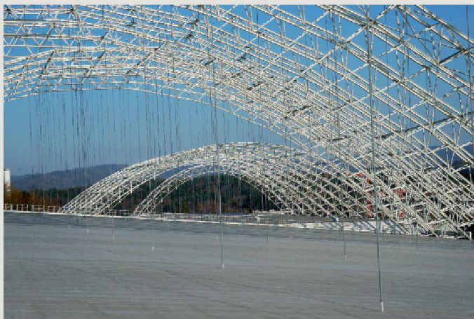
Arcs en treillis pour charpente métallique de grande portée : dépôt de déchets spéciaux SMDK, Kolliken. Entreprise totale : ARGE SMDK Infra (Marti/Züblin); conception de la construction acier : Züblin Stuttgart. (Photo SMDK Kolliken)
