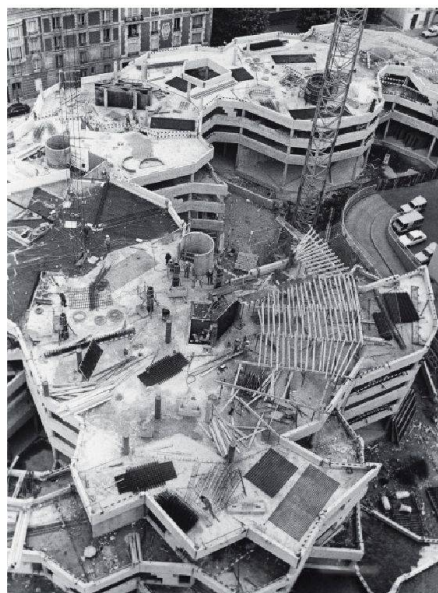
Le Liégat en construction (Photo archives de Renée Gailhoustet)
