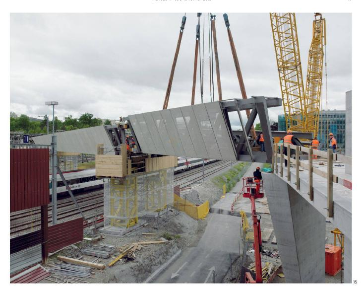
La mise en place de la structure métallique au-dessus des voies s'est faite principalement de nuit. Le planning de pose (jours et heures) de chaque tronçon a dû être établi plus d'une année à l'avance, puisque certaines opérations nécessitaient d'interrompre le trafic ferroviaire entre Lausanne et Genève ou encore de couper simultanément l'alimentation électrique des gares de Cornavin, de la Praille et de Genève-Aéroport.
