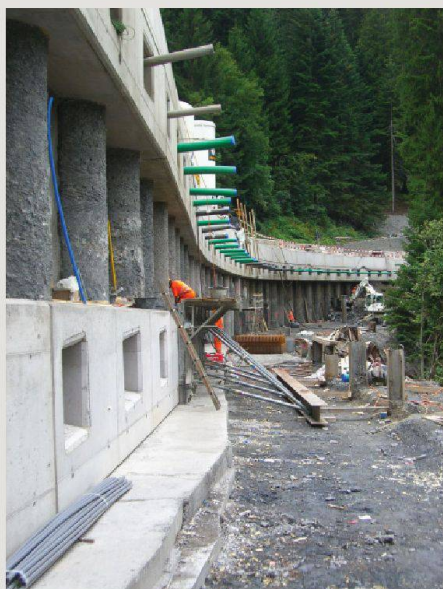
Confortement de pente à Schin: H 417a Thusis – Tiefencastel; maître de l'ouvrage: Canton des Grisons; conception: Dr. Vollenweider AG, Zurich (Photo: Roman Richner, Zurich)
