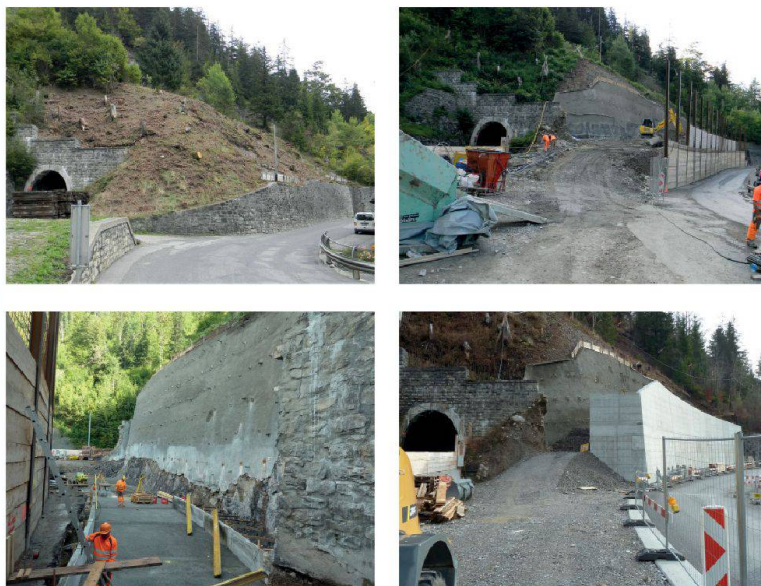
Mur de soutènement le long du tunnel MOB
