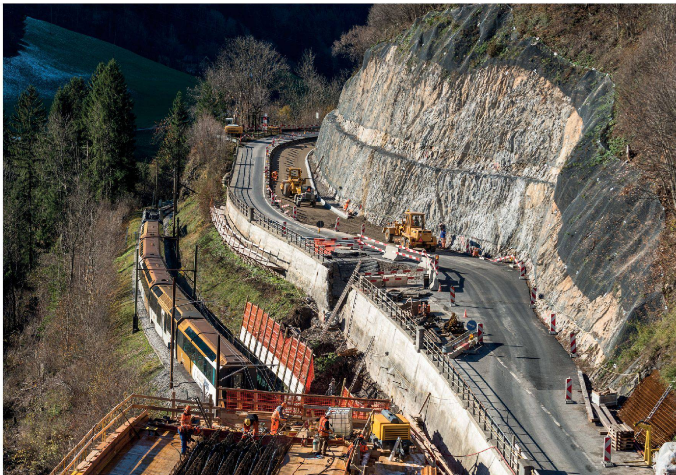
Mur de soutènement le long du tunnel MOB
