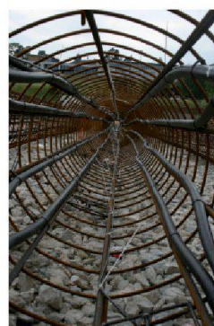
Équipement d'un pieu énergétique (Photo LMS-EPFL)
