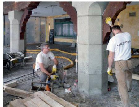
Au cœur de la vieille ville de Lucerne, au bord de la Reuss et à quelques minutes de la gare, il s'agissait de conserver, lors d'une transformation, les arcades d'une maison datant de 1596. L'opération de stabilisation mène à une augmentation des charges exercées par l'immeuble. Aussi, il fut fait appel à *Uretek (Suisse) SA* pour renforcer le sol de fondation afin de prévenir tout risque de tassement supplémentaire.
