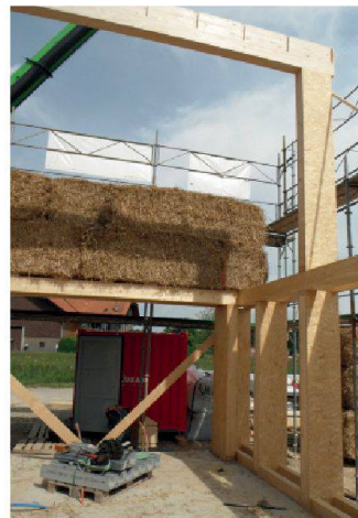
1 Vue depuis le salon sur les escaliers menant au premier étage 2 à 5 Montage de la charpente et mise en place des bottes de paille
