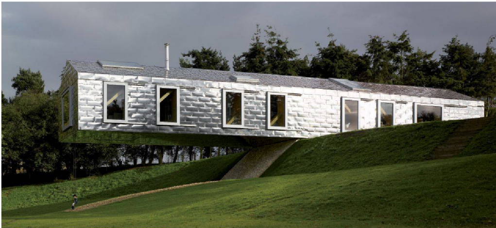
1 Wozoco. Le porte-à-faux, porté à son paroxysme (© Rob 't Hart) < Balancing barn. La maison sur le point de basculer (© Edmund Sumner)
