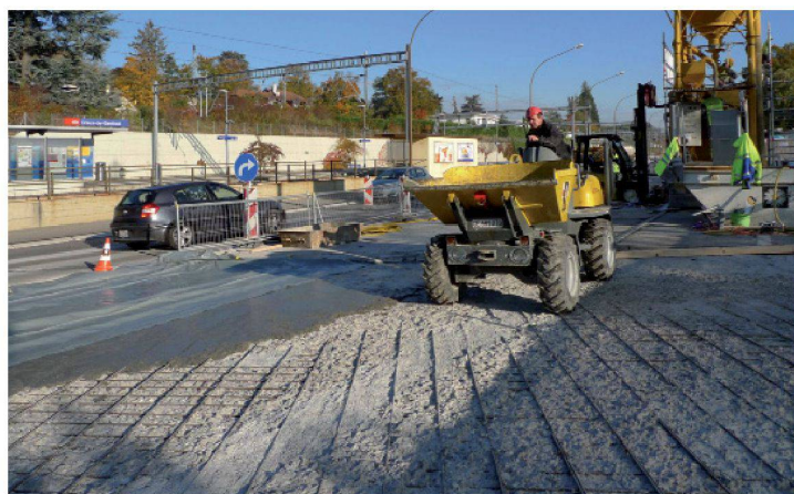
Fig. 6 : Vue d'ensemble des travaux d'application de BFUP sur la dalle de roulement du P.I. du Creux de Genthod (1 ère étape)
