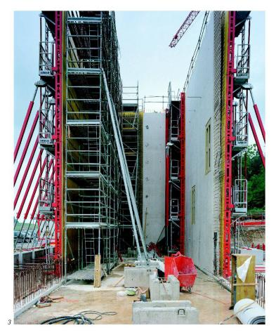
Sur cette base, le choix définitif du matériau s'est tourné vers un béton avec du ciment blanc qui serait mis en place dans des coffrages en panneaux avec trois plis verticaux. La qualité du fini a été obtenue grâce à une étude précise de la formulation du béton, un plan de contrôle et une préparation spécifique des équipes travaux avant la mise en œuvre (réalisation d'un « mur témoin » pour validation avec les ouvriers chargés du bétonnage).
