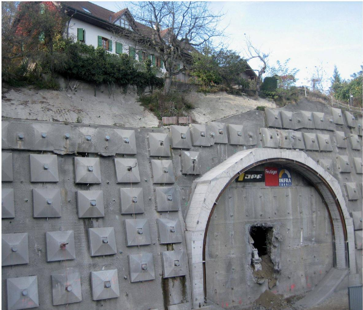
Fig. 1 : Percement du front d'attaque est, avec portique en béton et bâtiment à l'axe du tunnel
