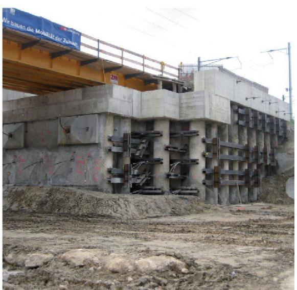
se compose de quatre niveaux d'ancrages sur la hauteur totale de la fouille, respectivement trois niveaux sous le PI, où le radier de ce dernier sert de bouton.
