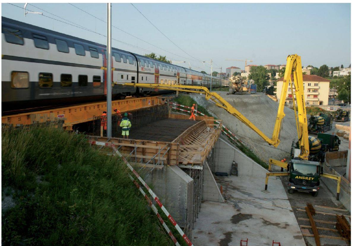
Fig. 9: Fondations des ponts provisoires PP2
