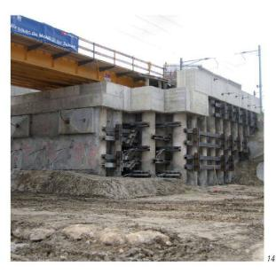
se compose de quatre niveaux d'ancrages sur la hauteur totale de la fouille, respectivement trois niveaux sous le Pl, où le radier de ce dernier sert de buton.
