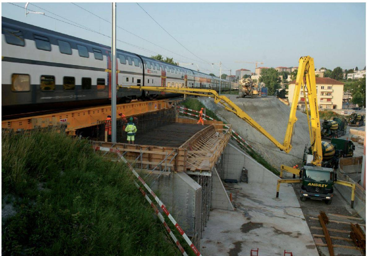
Fig. 9 : Fondations des ponts provisoires PP2
