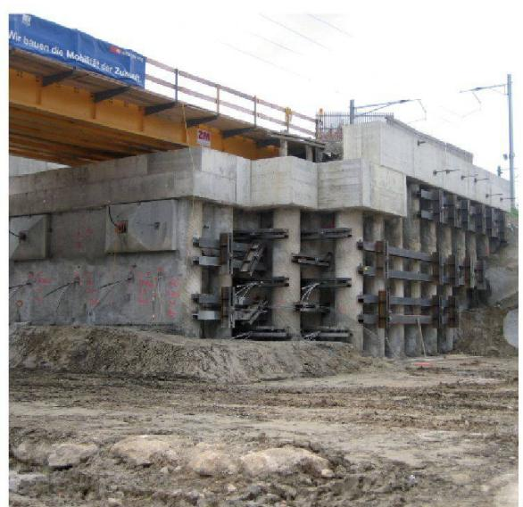
se compose de quatre niveaux d'ancrages sur la hauteur totale de la fouille, respectivement trois niveaux sous le PI, où le radier de ce dernier sert de bouton.
